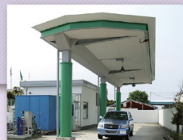
大阪水素ステーション
